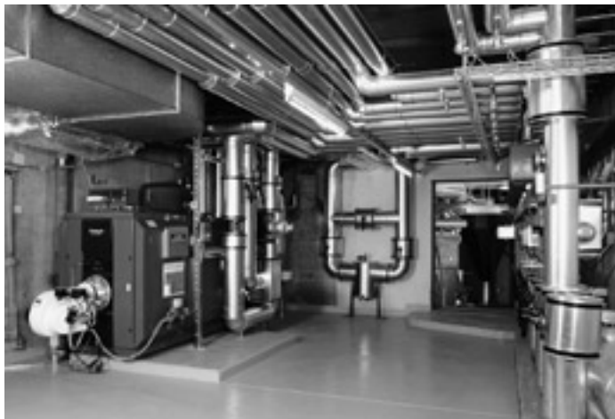
Spitzenlast-/Übergangskessel
