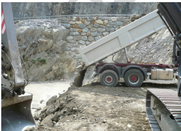
Abb. 5: Baumaschinen und Transportfahrzeuge müssen regelmässig vor Ort gereinigt werden.
