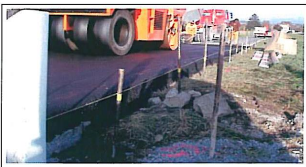
Seitenansicht Belagseinbau und Schnurgerüst
