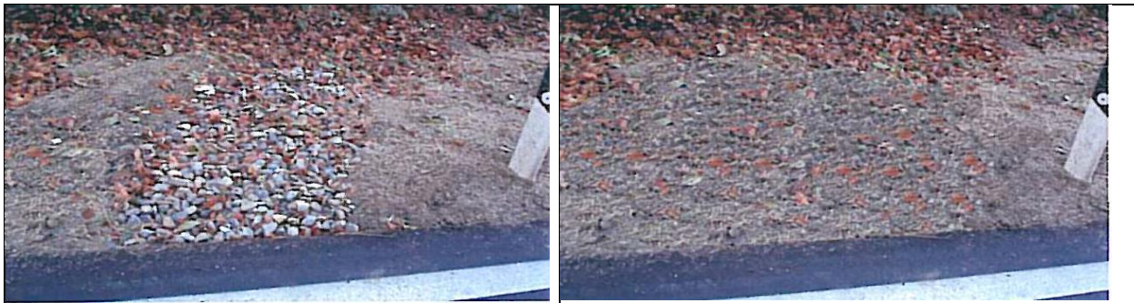
Versickerung im Bankett, auf dem Bild rechts ist der Oberboden (Humus) eingebaut
