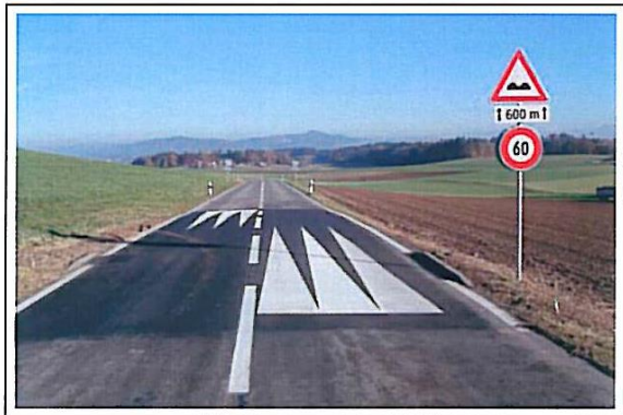
Fertiggestellte Bodenwelle mit Signaltafel
