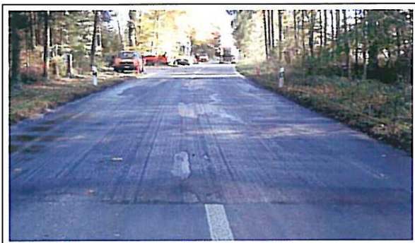
Deckbelag auf Länge der Bodenwelle abgefräst
