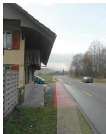
Foto B: Gehweg in Blickrichtung Westen.
