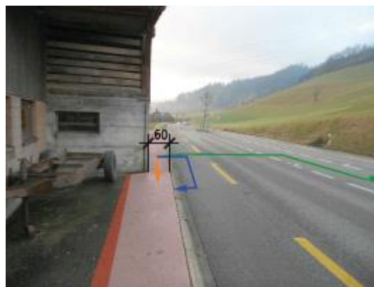
Foto D: Gehweg in Blickrichtung Westen an der Engstelle Rünkhofen
