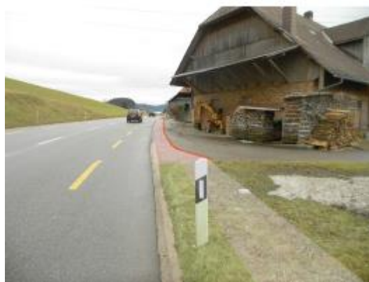
Foto C: Gehweg in östlicher Blickrichtung an der Engstelle Sackacker.
