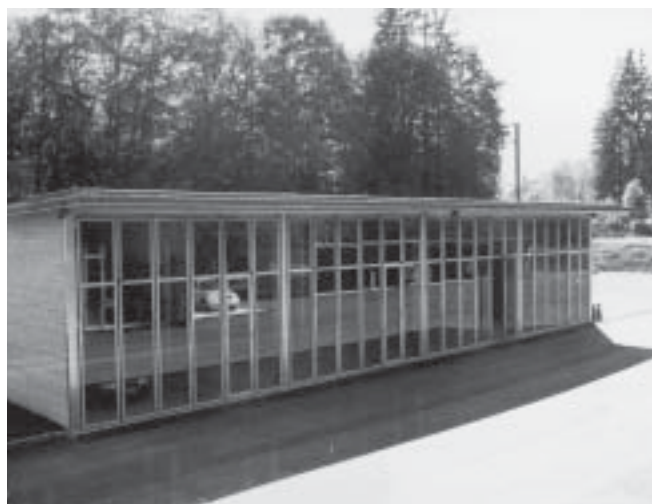
Bilder: Hauptgebäude Pflugunterstand Einstellhalle
