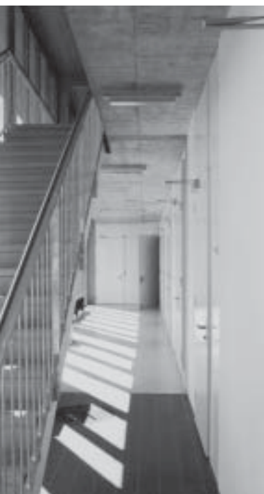
Werkhof Gesamtsicht Treppe Hauptgebäude
