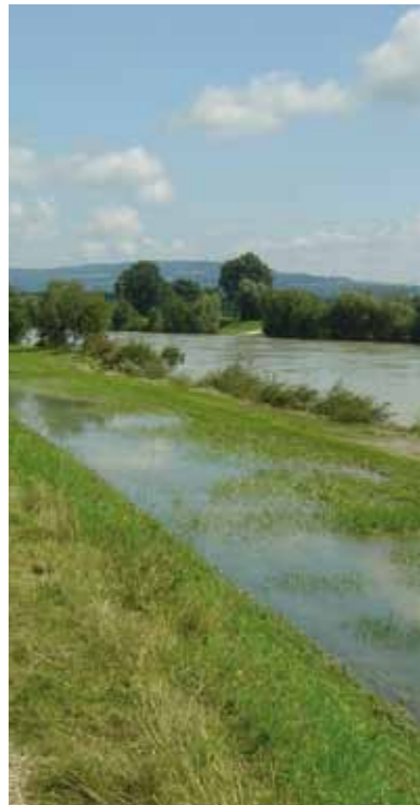
Der Hagneckkanal soll wieder hochwassertauglich werden.
